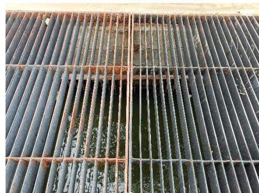
มีตะแกรงดักขยะก่อนระบายน้ำออก
